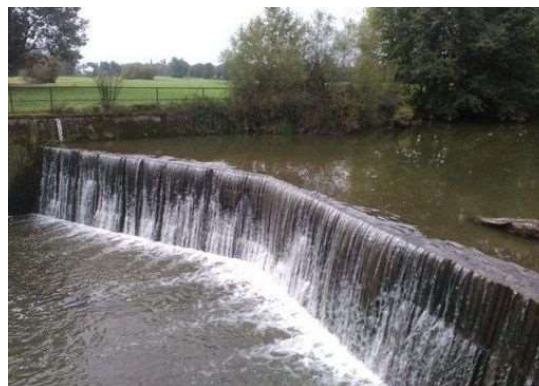
Studénka, ř. km 786,84, Odra
